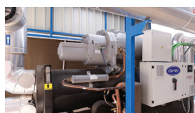
30XWH kylaggregat av typen vatten-till-vatten
