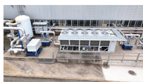
30KAV kylaggregat av typen luft-till-vatten
