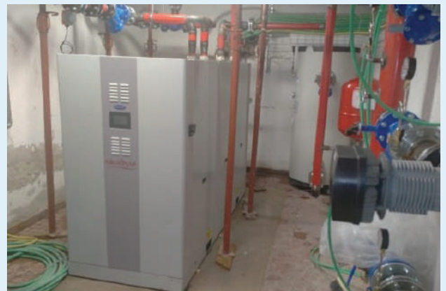
Po: kotłownia po pracach związanych z instalacją nowej pompy ciepła
