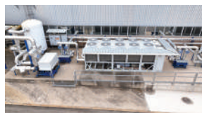
30KAV lucht/water koelmachines
