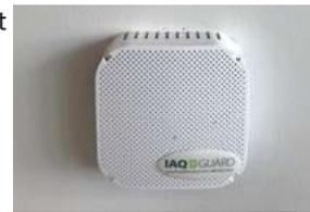
**La surveillance de la QAI** en continu permet d'identifier les problèmes de QAI et de vérifier l'efficacité du système de filtration et de dépollution de l'air dans le bâtiment.
