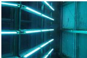
**La technologie d'éclairage UV-C** émet de l'énergie qui cible et lutte contre les polluants dans l'air, notamment les micro-organismes, bactéries, virus, moisissures et autres polluants volatils présents sur la batterie, pour rallonger la durée de vie de l'équipement.
