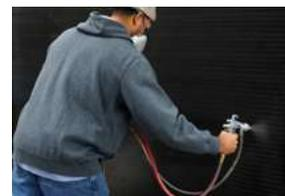
**Le revêtement de batterie antimicrobien et anti-corrosion** permet de limiter la croissance d'agents pathogènes et de micro-organismes sur les batteries, pour une optimisation de leur efficacité.
