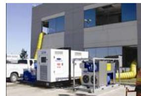
**Les systèmes de location Carrier** fournissent des solutions temporaires de chauffage, de ventilation et de climatisation (CVC), qui viennent compléter ou remplacer vos solutions, pour aider à rouvrir les bâtiments rapidement et en toute sécurité, dans le respect des exigences en matières de ventilation et de QAI.
