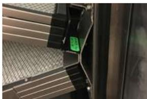
**Les filtres électrostatiques** utilisent l'électricité statique pour capter les particules qui traversent le filtre et ainsi protéger les bâtiments des particules microscopiques dangereuses.
