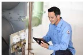
**Le démarrage des équipements Carrier** permet de garantir que les appareils CVC sont correctement mis en route et qu'ils fonctionnent comme prévu, afin de s'assurer que le bâtiment peut être occupé.
