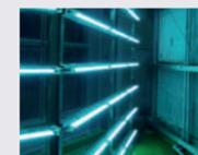
dispositivos que utilizan luz UVC, especialmente diseñados para atacar a los virus, así como oxidación fotocatalítica UV para ayudar a eliminar los compuestos orgánicos volátiles y mejorar la calidad del aire interior (IAQ).
