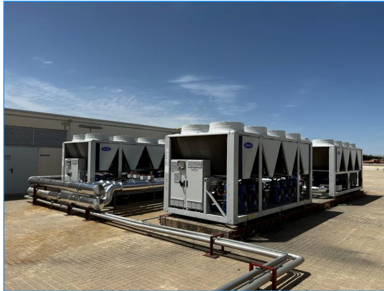
Bomba de Calor Aire-Agua 4 x 526 kW
