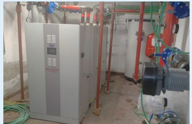
Después: sala de calderas tras la intervención con la nueva bomba de calor
