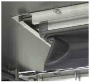
Detail flexible fan connection
