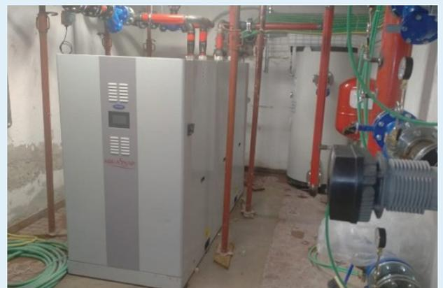
Nachher: Heizungsraum nach dem Einbau der neuen Wärmepumpe
