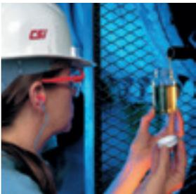
Die Ölprobe wird im Zuge der Wartung, bzw. bei einem Kundendienstesatz entnommen und an das Carrier-Vernolab-Labor geschickt.
