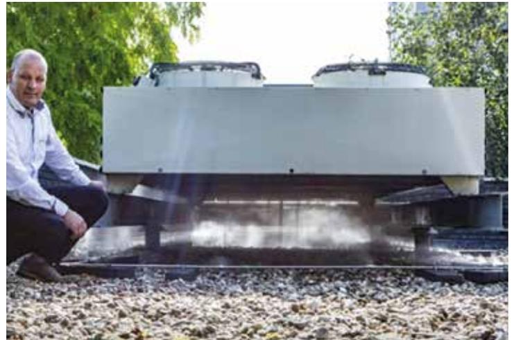
Système de nébulisation (pompe) associé à un système de régulation des émissions
