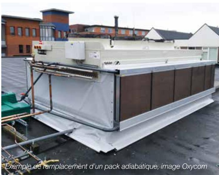
Exemple de remplacement d'un pack adiabatique, image Oxycom
